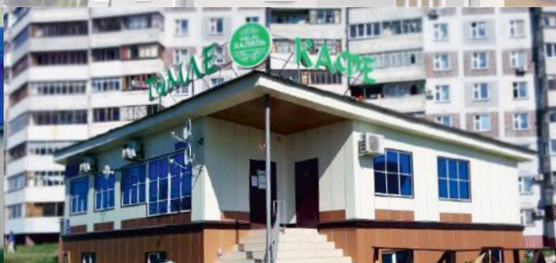
г. Казань, ремонт фасада
