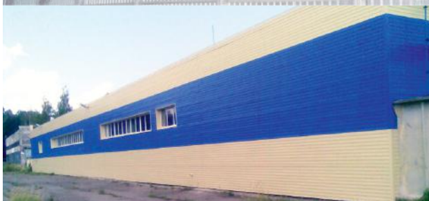
Высокая гора, РТ, ремонт фасада
