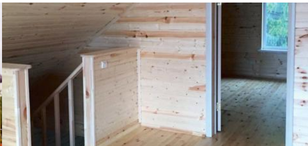
п. Октябрьский, РТ, устройство мансарды
