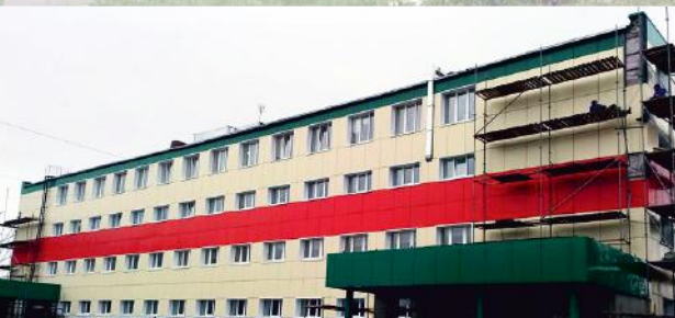
г. Казань, ремонт и утепление фасада
