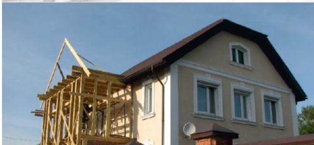
г.Казань, каркасная надстройка 2 этажа
