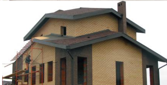
д. Обухово, РТ, каркасная надстройка 3 эт.
